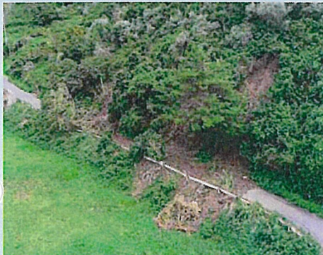
土砂崩れ（西ノ島町浦郷地区）
