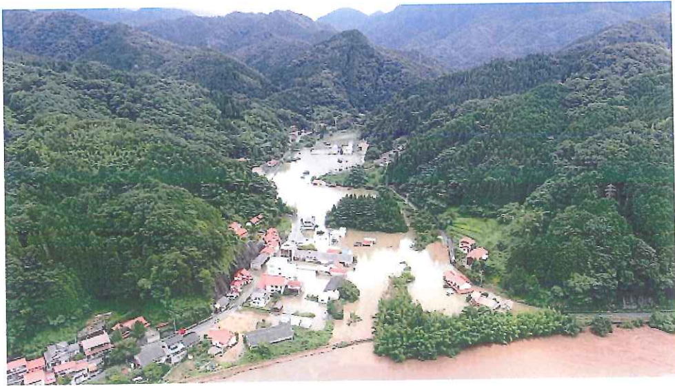
令和2年7月豪雨による氾濫（川本町）
