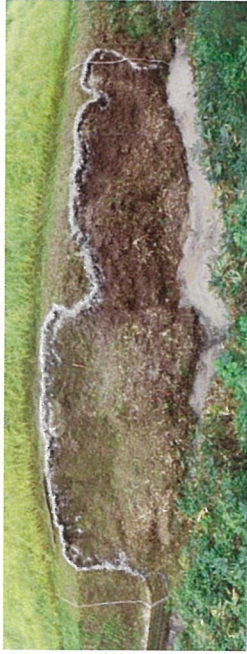
河川崩落(奥出雲町)
