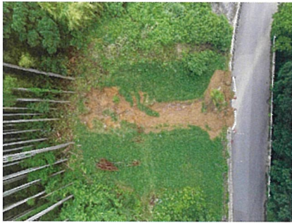
町道脇土砂崩れ(隠岐の島町)
