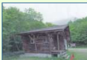
修復後写真①
